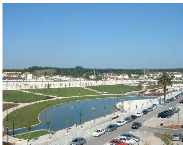
Fotos 2 – Intervenção POLIS – Parque da CERCA (antes e depois)
