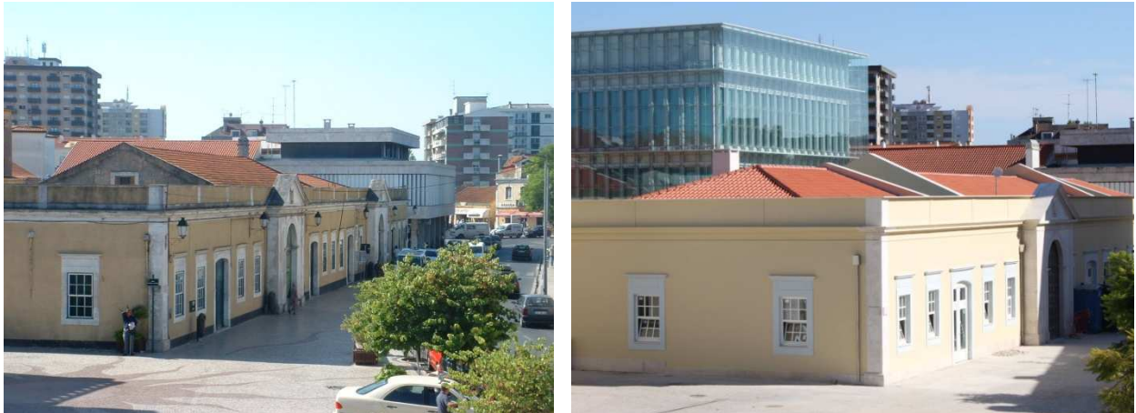
Fotos 8 – Parcerias para a regeneração Urbana – Intervenção Fábrica da Resinagem (antes e depois)
