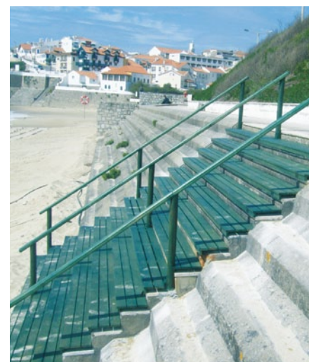
ACESSOS À PRAIA DE SÃO PEDRO DE MOEL
