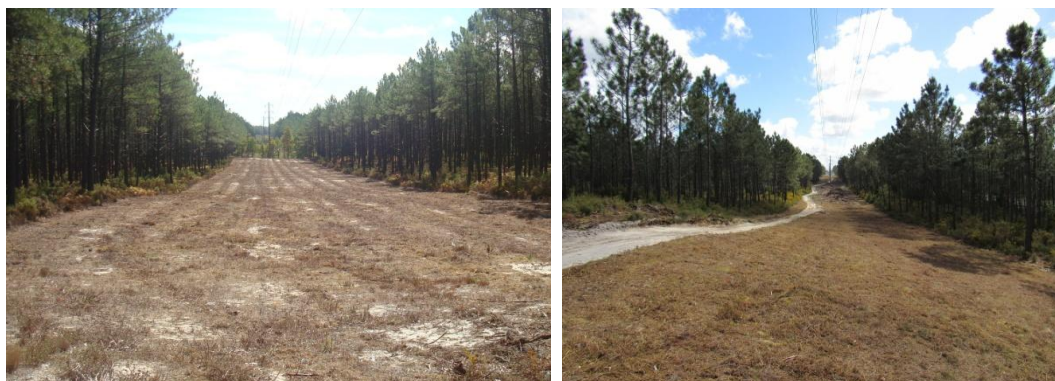
Fig.18 e Fig.19 - Faixa de gestão de combustível junto da rede elétrica
