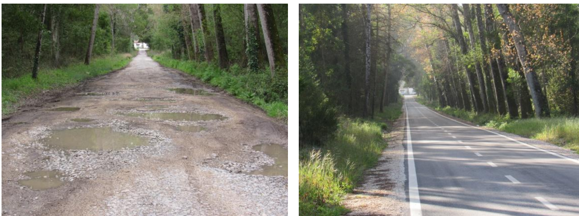
Fig. 8 e 9- Rede viária florestal junto do Tremelgo (antes e depois da intervenção)
