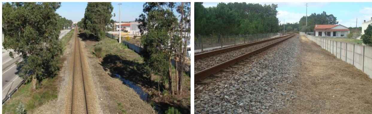
Fig.20 e Fig.21 - Faixa de gestão de combustível junto da rede ferroviária
