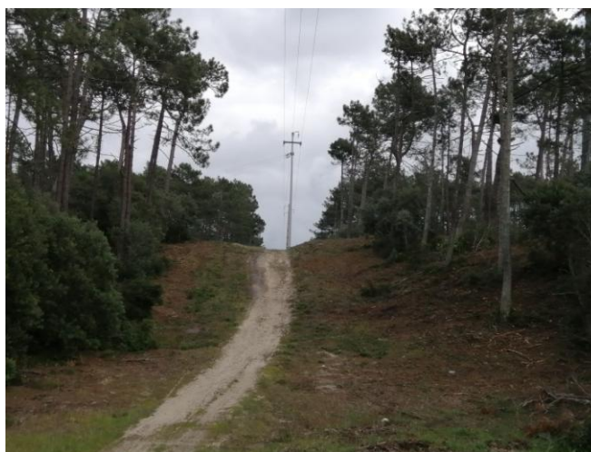
Fig. 32 - Intervenção na FGC junto da rede elétrica em São Pedro de Moel
