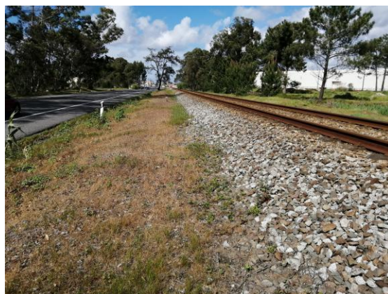
Fig. 33 - Intervenção na FGC junto da rede ferroviária
