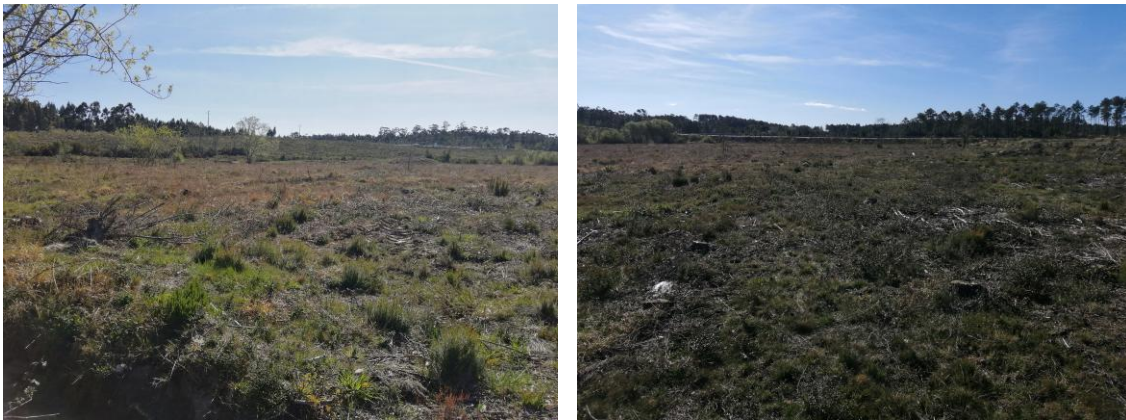
Fig. 25 e 26- Intervenção junto da zona industrial da Marinha Grande
