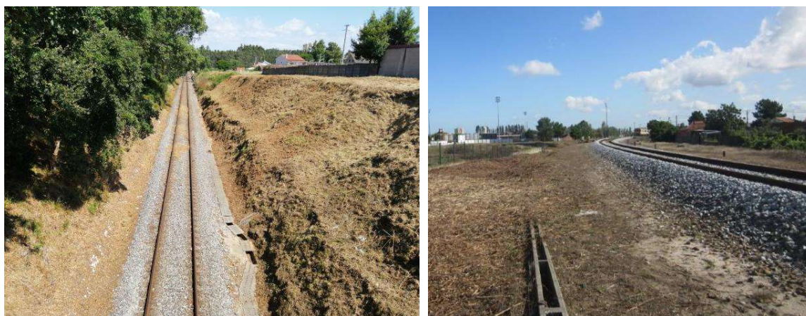
Fig. 17 - Intervenção na FGC junto da rede ferroviária
