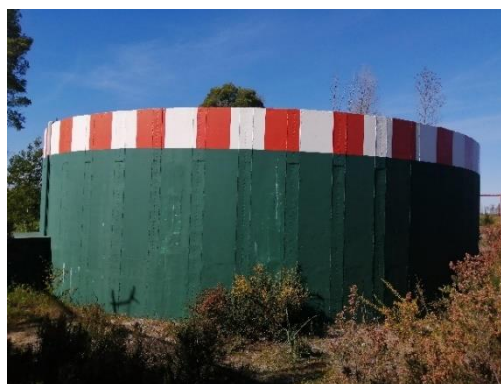
Fig. 6 - Reservatório do Tremelgo, localizado na Mata Nacional de Leiria
