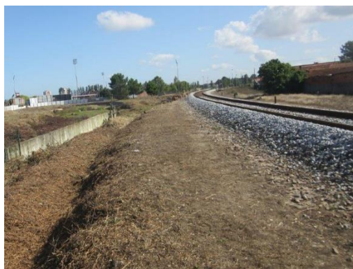
Fig. 20 - Intervenção na FGC junto da rede ferroviária
