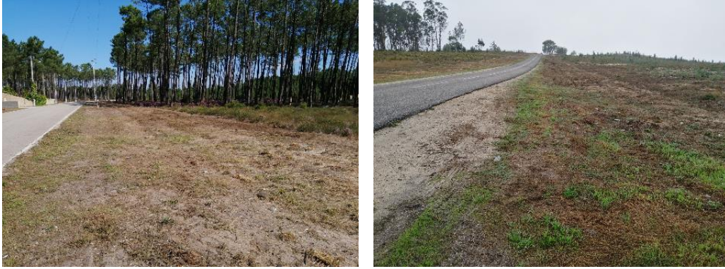
Fig. 16 e 17 - Intervenção junto da rede viária municipal
