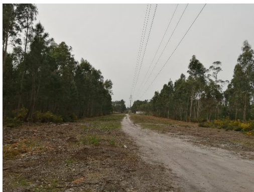
Fig. 19 - Intervenção na FGC junto da rede elétrica
