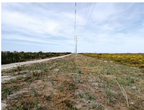
Fig. 16 - Intervenção na FGC junto da rede elétrica
