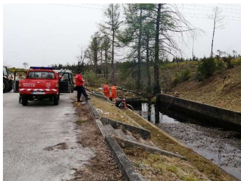
Fig. 11 - Intervenção no ponto de água da Formosa
