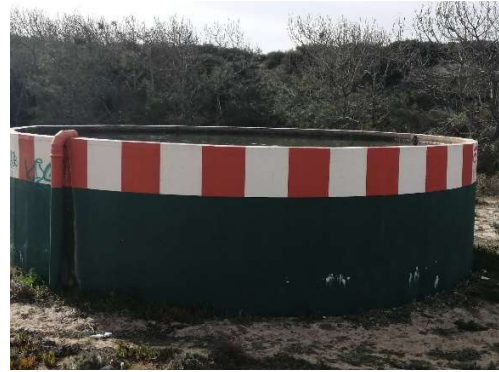
Fig. 6 - Reservatório do Samouco, localizado na Mata Nacional de Leiria
