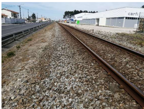
Fig. 17 - Intervenção na FGC junto da rede ferroviária
