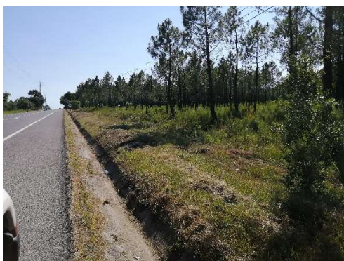
Fig. 14 - Intervenção junto da rede viária nacional e regional
