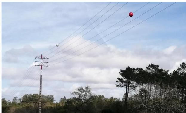
Fig. 18 – Colocação de esferas de sinalização e pintura dos postes
