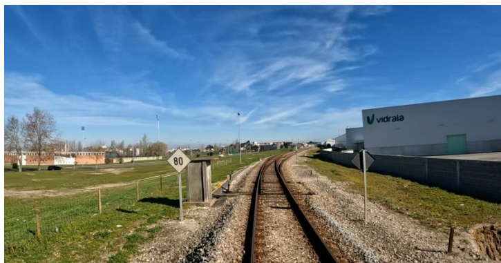
Fig. 17 - Intervenção na FGC junto da rede ferroviária
