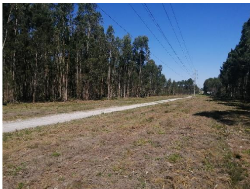
Fig. 16 - Intervenção na FGC junto da rede elétrica
