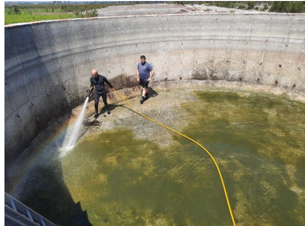
Fig. 13 - Intervenção no ponto de água do Tremelgo
